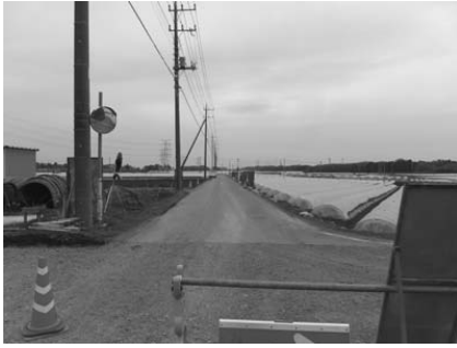
早期着手が期待される道路改良工事
