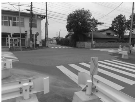
施工中の貝谷十字路
