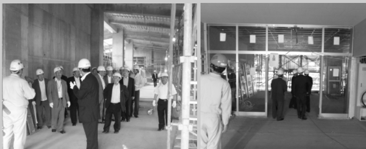
一中学校改築現場内（左：2階廊下 右：1階昇降口）
