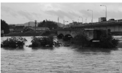
増水した鬼怒川の様子 (9月10日午後1時頃 長塚橋付近)
