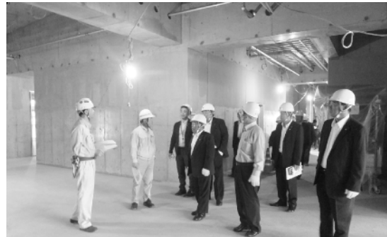
内部の様子（1階廊下）
