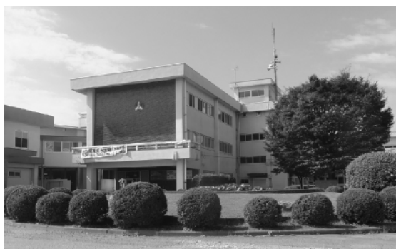
新校舎の完成に伴い取り壊される東中旧校舎
