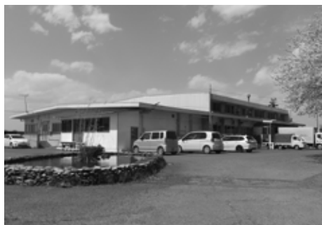
老朽化した給食センター
