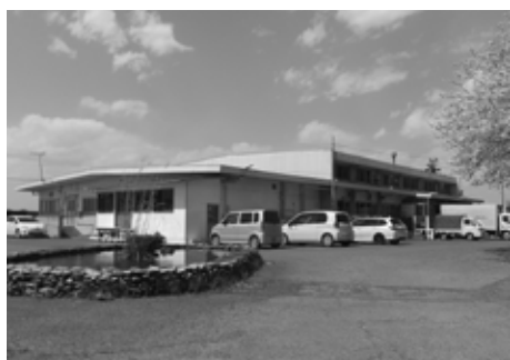
老朽化した給食センター
