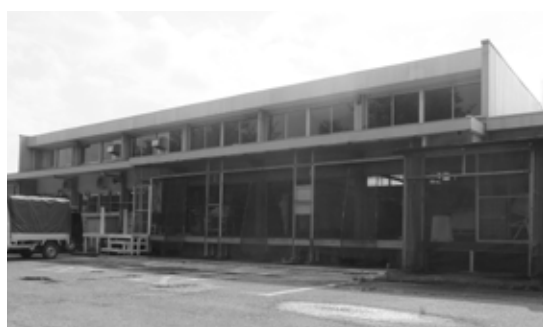
老朽化している現在の給食センター
