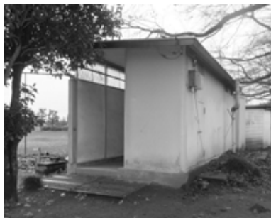
改修予定の東路田運動公園トイレ
