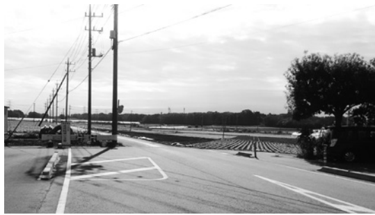
一級町道8号線の道路幅が狭くなる部分 (東蒔田)
