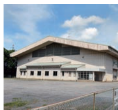
トイレ改修が 予定されている 体育センター
