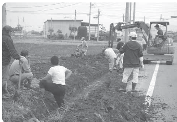
道路側溝の清掃
