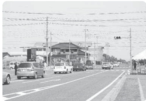
開通した主要地方道結城坂東線バイパス
