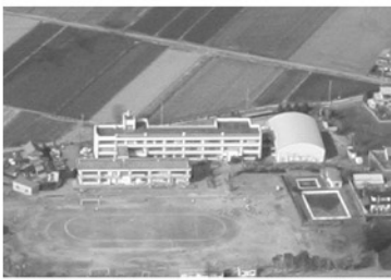
耐震補強工事を予定している西豊田小学校
