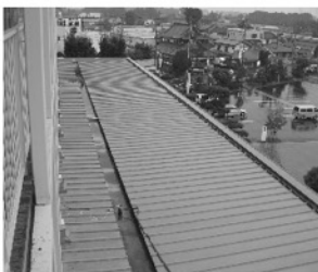
役場庁舎の町民ホール屋根部分
