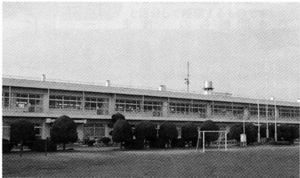
工事を実施する安静小学校の校舎
