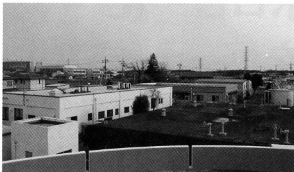
老朽化が進んでいる町の水道施設
