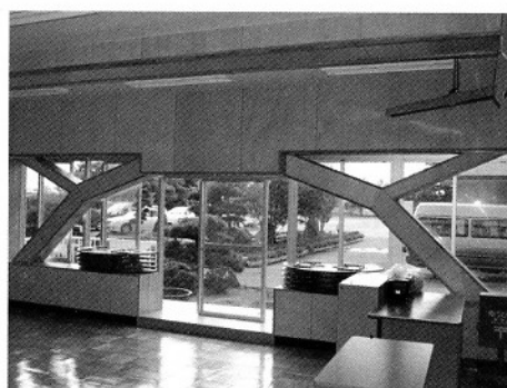
教室から見た耐震補強部分
