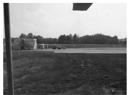
改築工事が始まった一中
