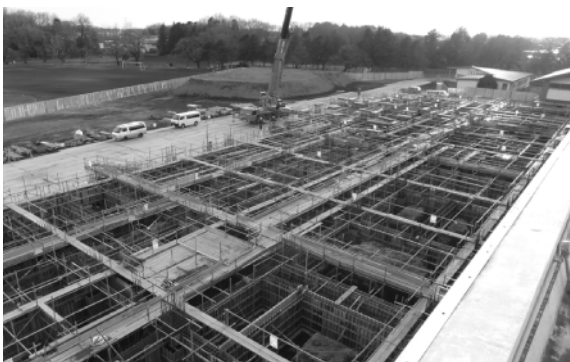
順調に進む改築工事（写真は基礎、配筋工事の様子）
