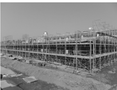
一中の改築状況（H26.3.28撮影）
