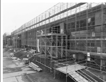
一中改築現場の状況（H26.7.9撮影）
