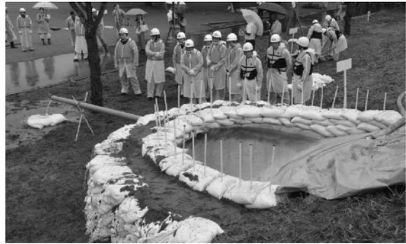
漏水の拡大を防ぐ月の輪工法
