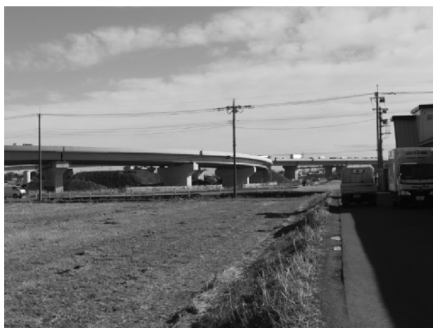
五霞 I C 付近から見た圏央道
