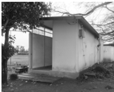
改修予定の東路田運動公園トイレ
