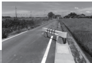
▶町道2394号線 (仁江戸地内)
