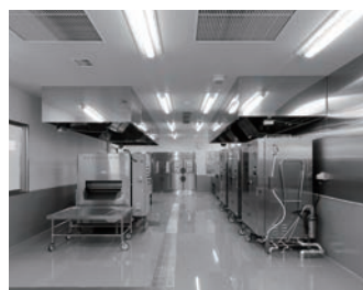
焼き物・揚げ物・蒸し物調理室 スチームコンベクションオーブンを導入し調理の幅が広がりました。
