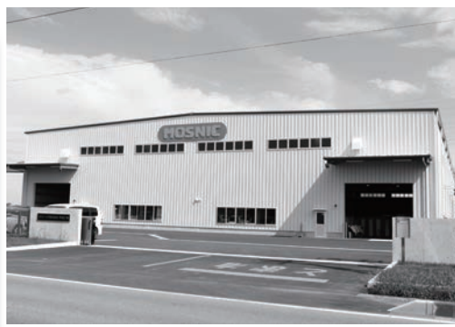
モスニック株式会社茨城工場の外観
