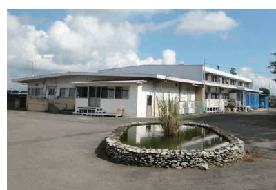
取り壊しになる旧学校給食センター（菅谷地内）
