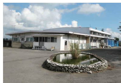
取り壊しになる旧学校給食センター (菅谷地内)
