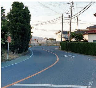
県道高崎坂東線のS字カーブ(粟野地内)
