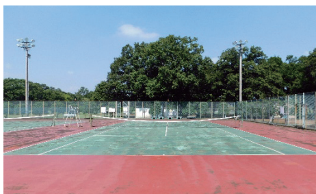
改修される町民公園テニスコート (写真は改修前のもの)
