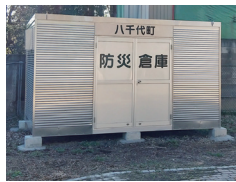
町が設置する防災備蓄倉庫
