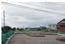
建設中の 筑西幹線道路 (西大山地内)
