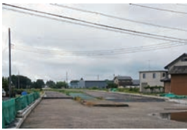
建設中の筑西幹線道路(西大山地内)
