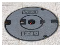
マンホールトイレ
