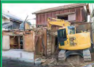
木造解体工事
