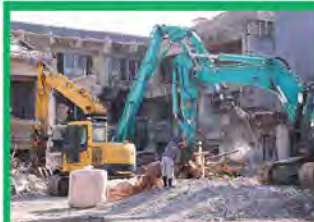
RC 解体工事
