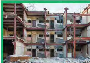
軽量鉄骨解体工事
