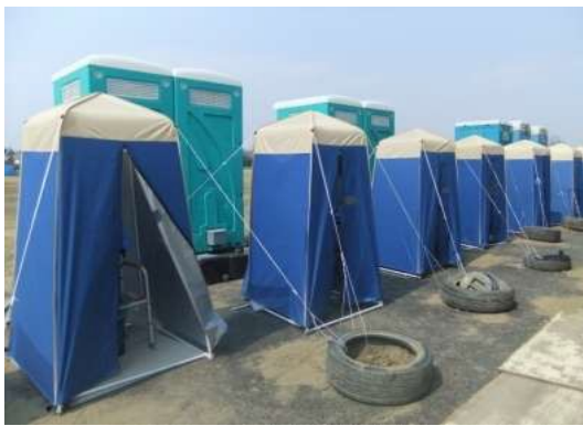
マンホールトイレ
