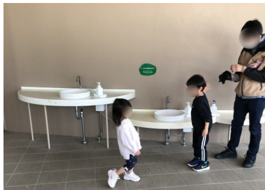
子どもに配慮した高さの手洗い
